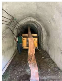
写真： 5.5MWと13.7MWにおいてトンネル工事が開始
