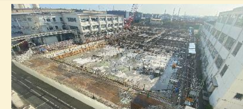
2026年4月の状況:鉄筋の組立工程
