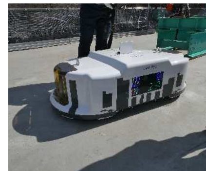
「T-iROBO®Slab Finisher」の適用
