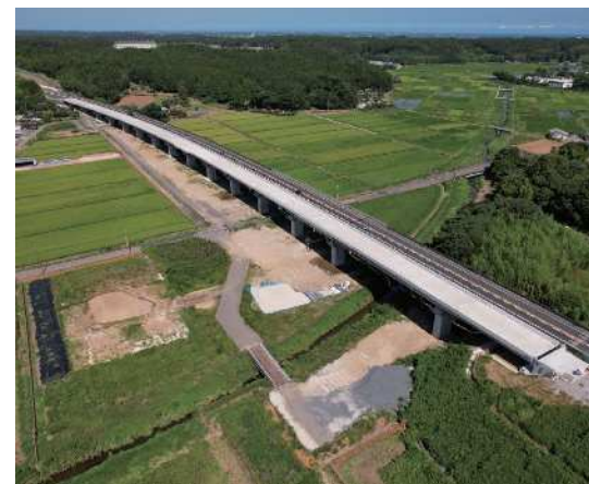
首都圏中央連絡自動車道 古和高架橋
