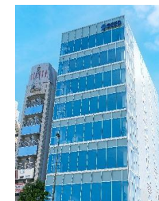
シード本社ビル
