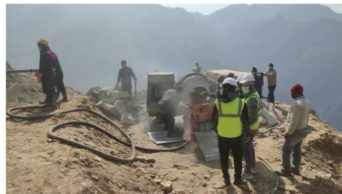
5.5MWと13.7MWにおいてトンネル工事が開始
