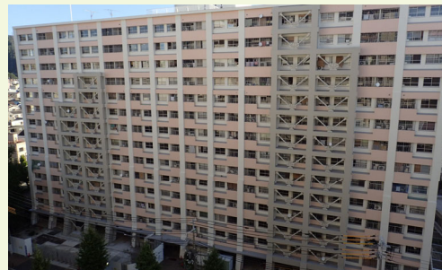
上湊川高層住宅高層住宅耐震等改修建築工事 (兵庫県神戸市)
