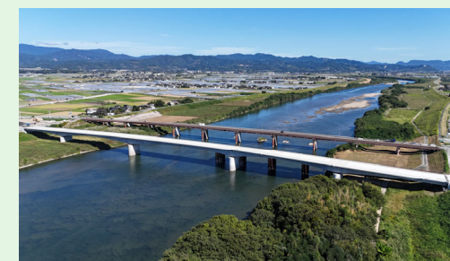
両筑橋 (2工区) (福岡県久留米市)
