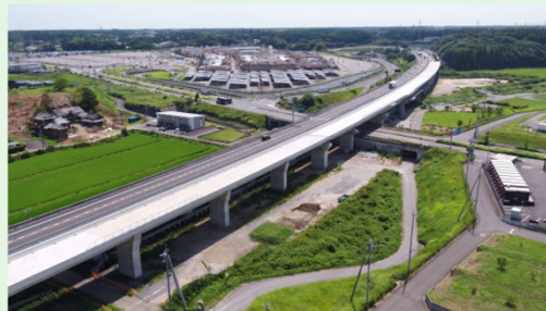
阿見高架橋 (茨城県稲敷郡)
