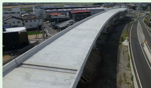
南吉田第2高架橋 (愛媛県松山市)
