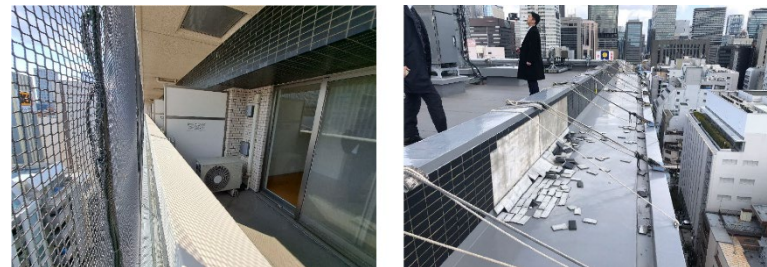
BEFORE 築18年が経過しタイルの剥離が激しく、外壁にネットを張り事故を防いでいる状態だった
