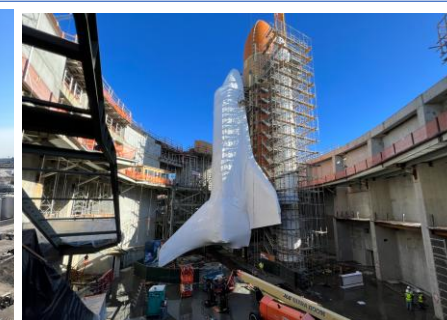
Type I L(混合セメント)納入例 17,000cyのコンクリート構造物向けに使用 The California Science Center内(ロサンゼルス)
