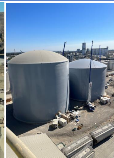
ストックトン・ターミナル増設工事中サイロ
