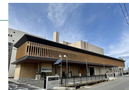
会津若松地方広域市町村圏整備組合向け新ごみ焼却施設の外観
