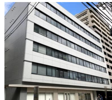
広島CDビル (テナント)
