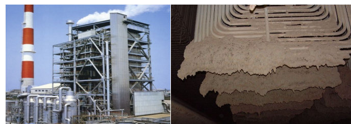
・大型火力発電ボイラーの外観 ・クリンカーの堆積した様子
