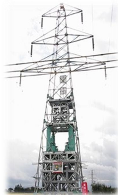
シンクロ工法 「タワーリフター80」 平成20年 特許取得
