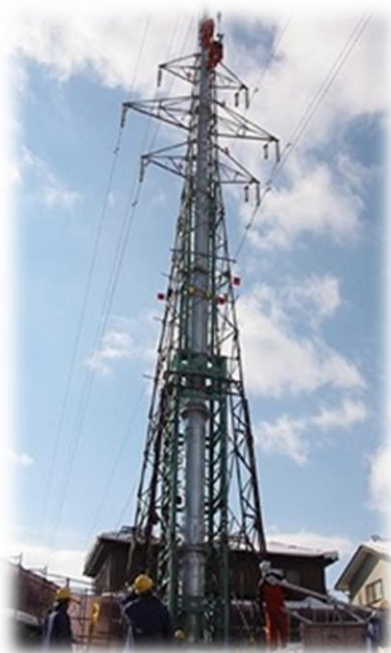
鋼管単体鉄塔組立工法 「スカイランスTY-33」 平成18年 特許取得
