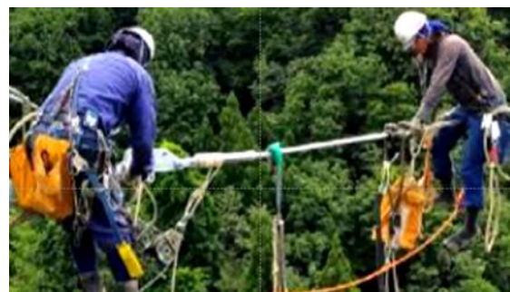
送電線架線工事の様子
