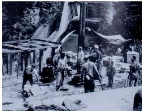
1963年 黒部ダム 電気工事完工
