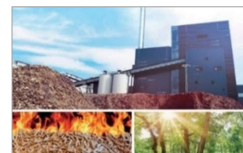
バイオマスリサイクル
