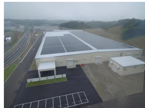
完成した新工場の外観
