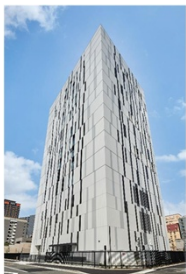
オブテージ曽根崎データセンター
