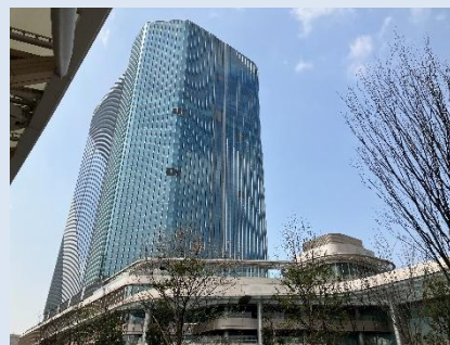
高輪ゲートウェイシティ再開発 電気設備設置（東京都）
