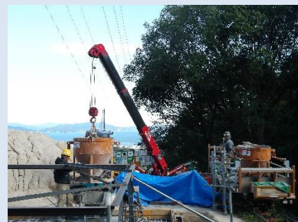
廿日市八幡線電線張替 (広島県)
