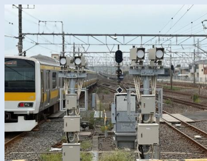
乗降確認モニタ用通信設備新設 (千葉県)
