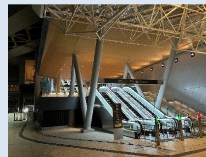
浜松町駅南口自由通路配電設備新設 (東京都)
