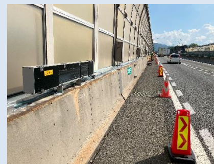
名神高速道路照明設備更新 （京都府）
