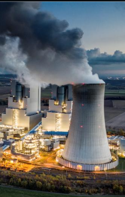
石炭火力発電所
