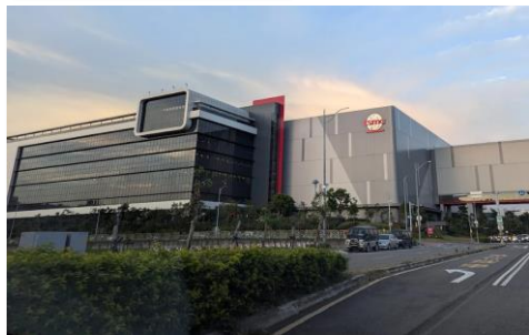
TSMC（台湾積体電路製造）の新竹工場群・高雄・嘉義の新工場にドアを納入 （写真は竹南にある「Advanced Backend Fab 6」）
