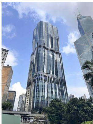
香港を代表する複合オフィスビル 「The Henderson」ビルに 自動ドアやフロント商品を納入
