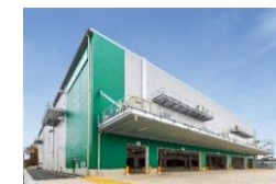
野田物流倉庫
