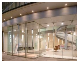
NTビル(エントランス)
