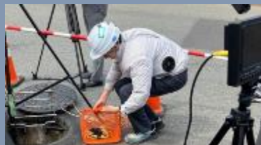
秋田市下水道管路ドローン調査
