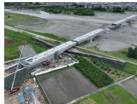
釜無川橋りょう 上部工
