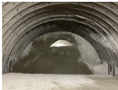
伊那山地トンネル (戸中・壬生沢工区) 本坑の貫通状況
