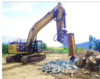
-パカット君工法-
