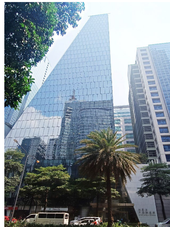
InfiniVANの入居ビル
