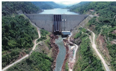
ナムニアップ1発電所
