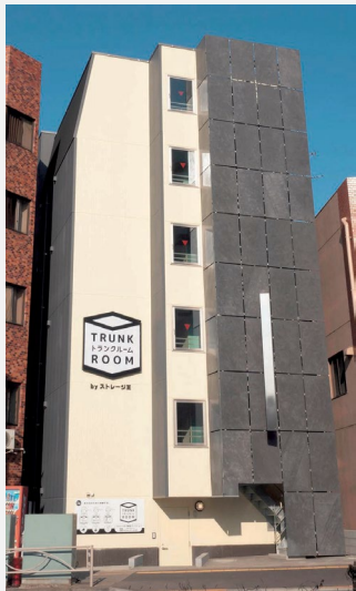
中板橋トランクルーム（東京都）
