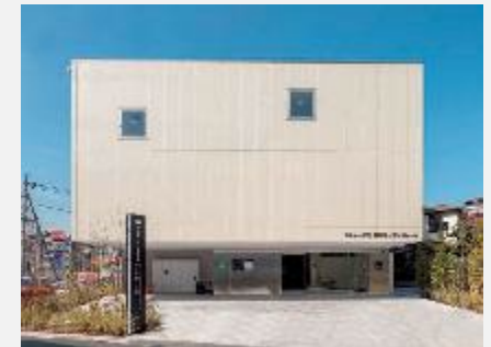
梶が谷トランクルーム (神奈川県) 外観
